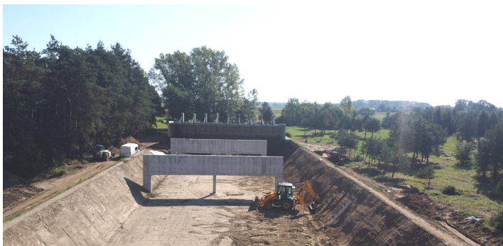
Strzelnica w trakcie budowy
