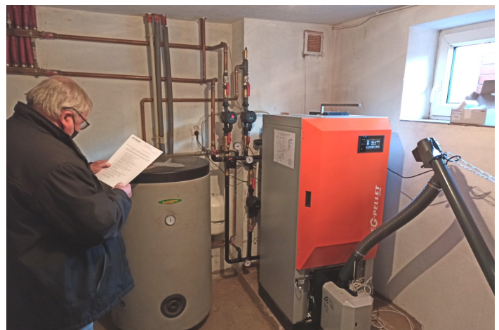
Montaż kotła na biomasę
