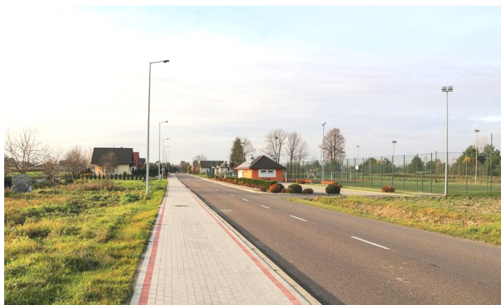
Wyremontowany ciąg pieszo-jezdny
