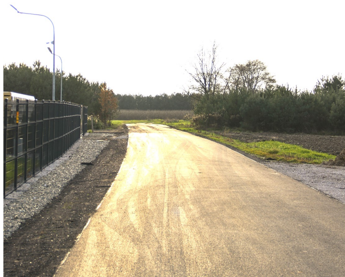
Droga powiatowa w Jagielle (tereny inwestycyjne)
