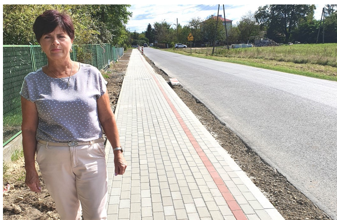
Chodnik wzdłuż drogi powiatowej Grzęska - Świętoniowa
