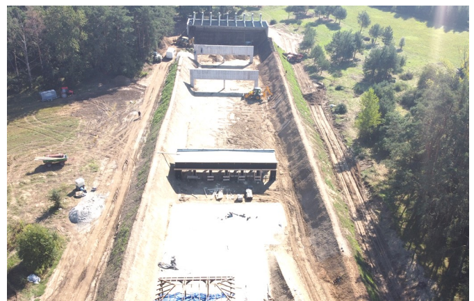
Widok budowy „z lotu ptaka”
